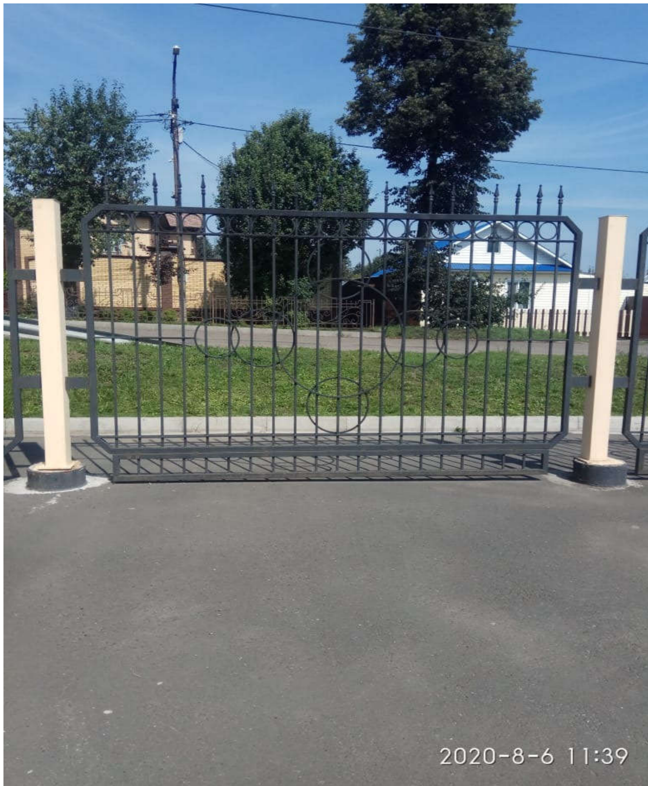
Ограждение по периметру парка
