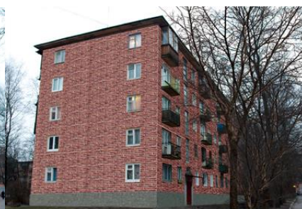
Фасад МКД после утепления термопанелями
