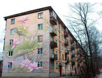
Фасад МКД после утепления термопанелями
