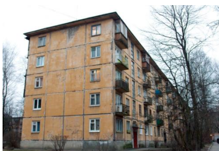
Фасад МКД до утепления термопанелями
